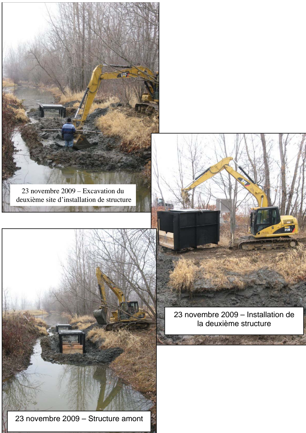
Figure 10 Installation de la structure amont le 23 novembre 2009
