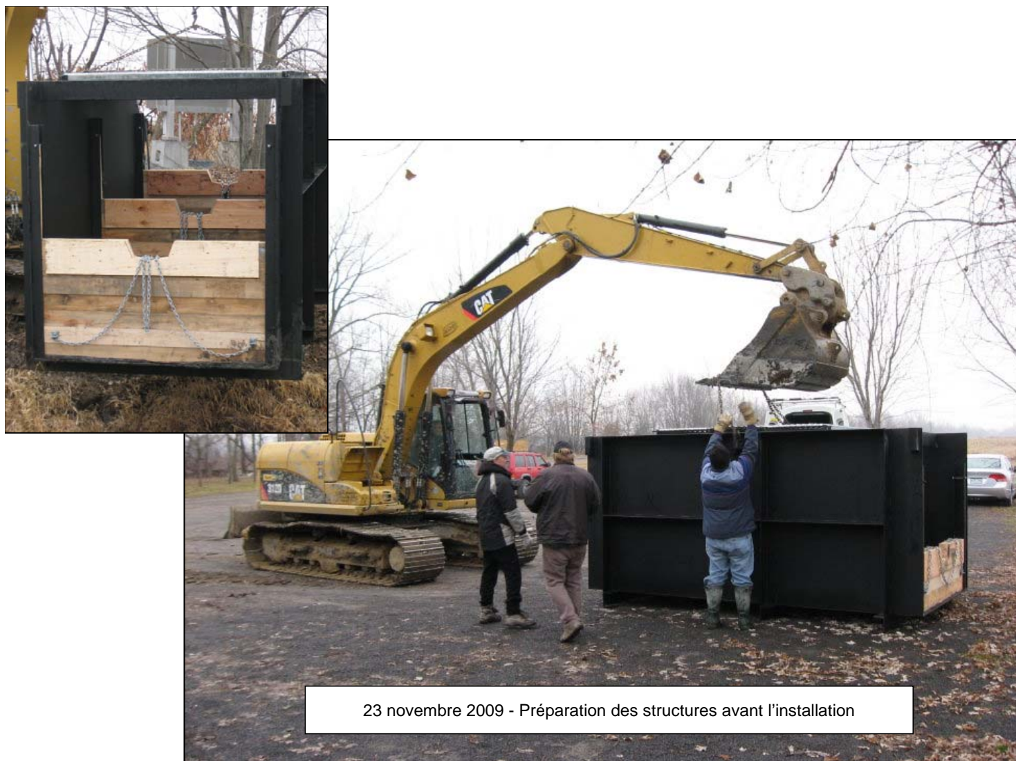
Figure 7 Préparation des structures le 23 novembre 2009
