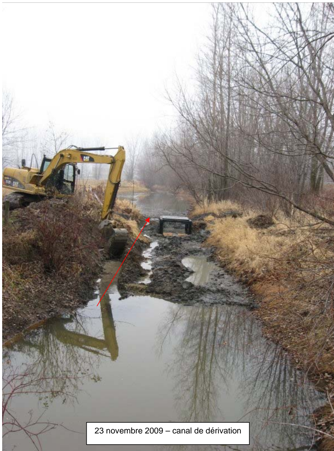
Figure 8 Aménagement du canal de dérivation le 23 novembre 2009
