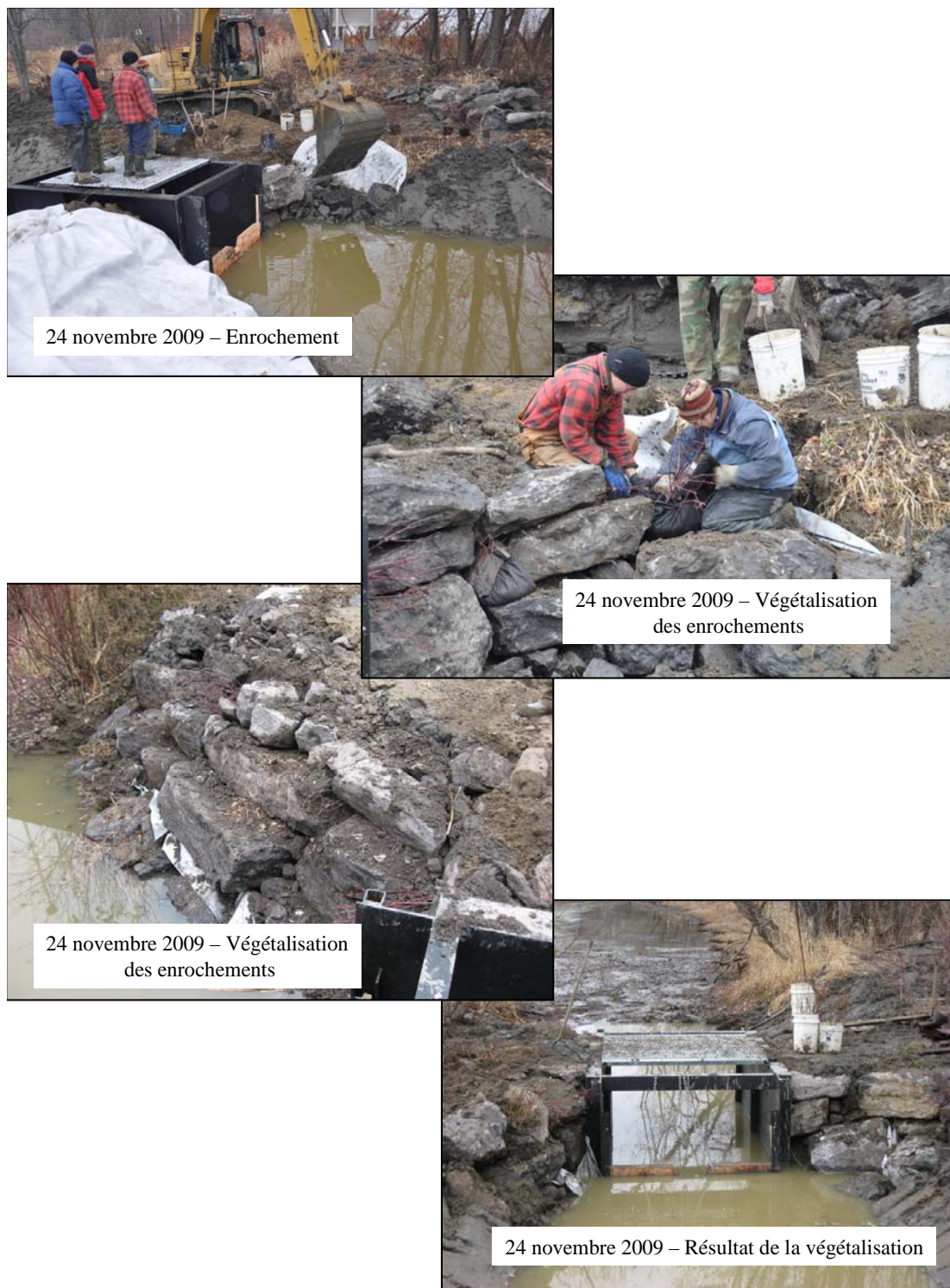
Figure 13 Seconde partie de l'enrochement et végétalisation le 24 novembre 2009
