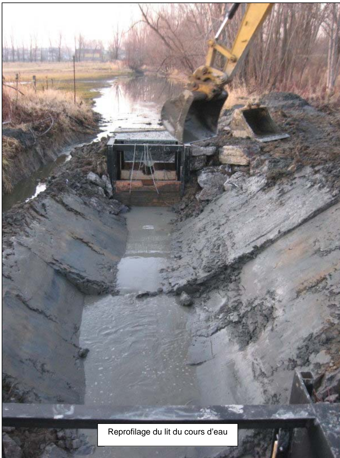
Figure 12 Reprofilage du lit du cours d'eau le 23 novembre 2009
