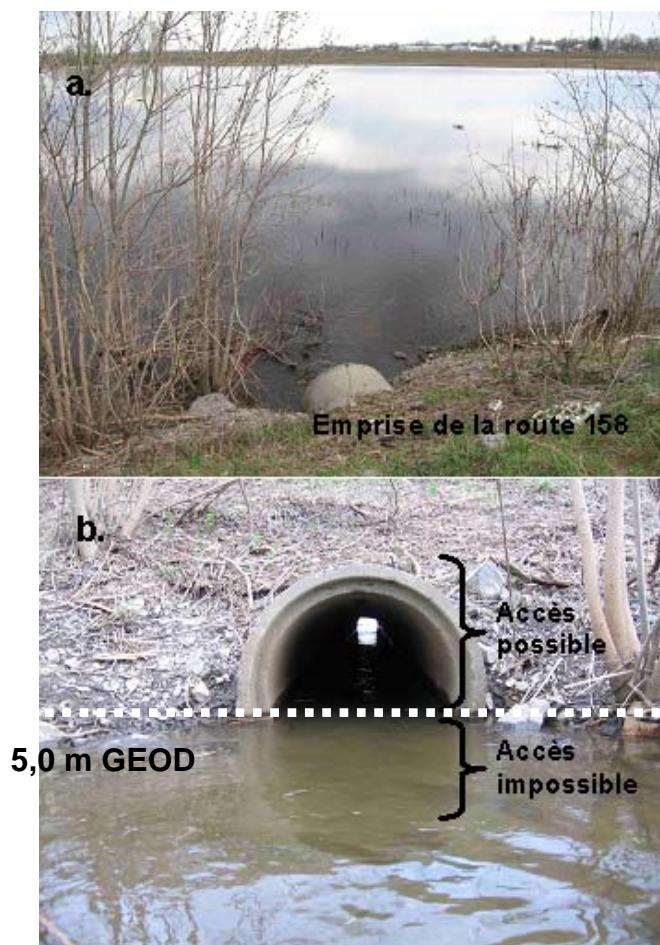
Figure 3 Problématique du ponceau de la route 158 à l'Île du Milieu : petite taille par rapport à la largeur du marais (a; localisation difficile pour les poissons) et structure trop élevée (b; accès impossible à la section ouest en période de faible niveau d'eau)
