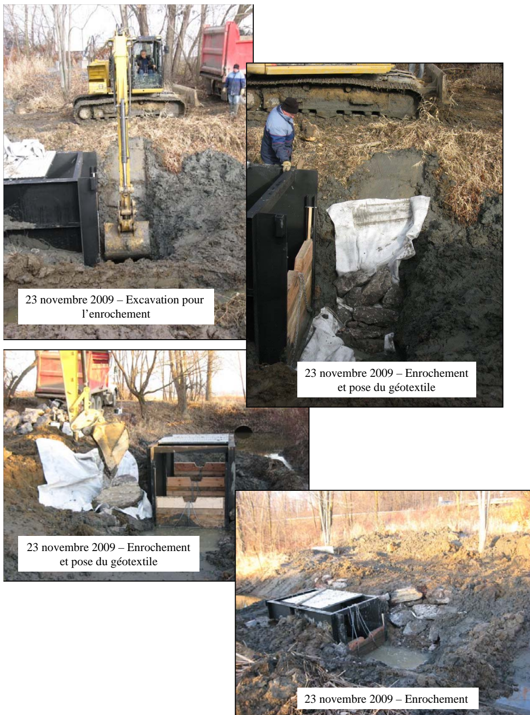
Figure 11 Première partie de l'enrochement le 23 novembre 2009
