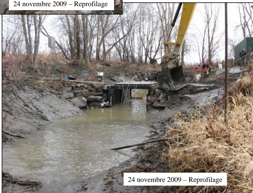
Figure 14 Reprofilage des berges le 24 novembre 2009
