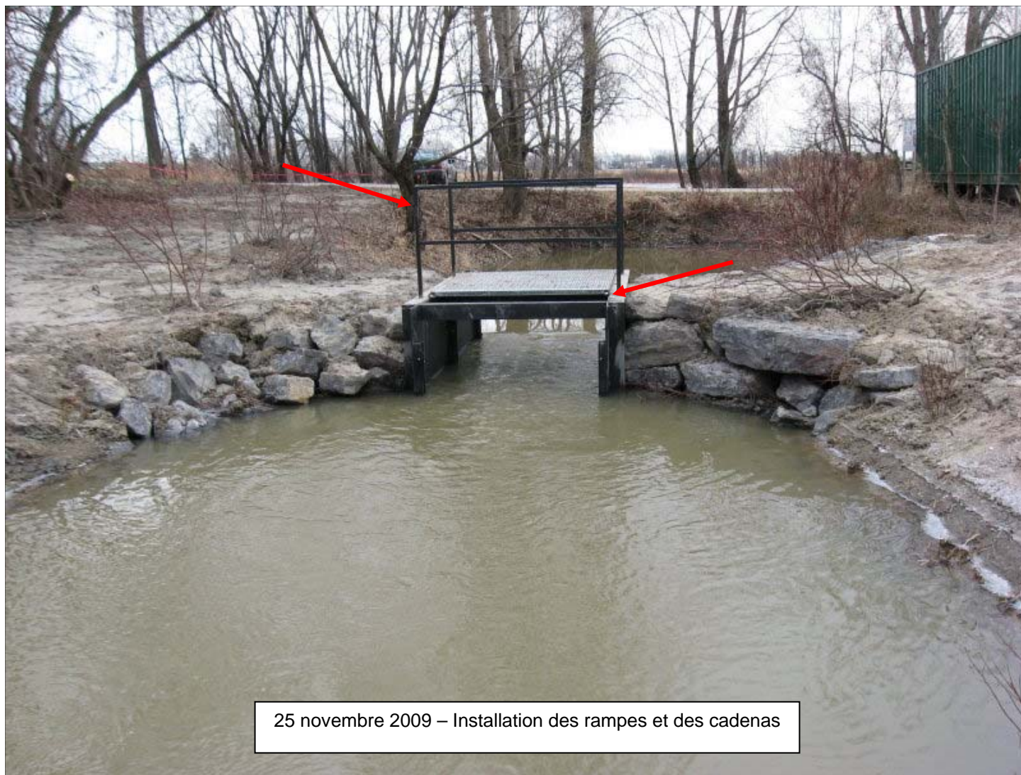
Figure 16 Installation des divers accessoires de sécurité le 25 novembre 2009
