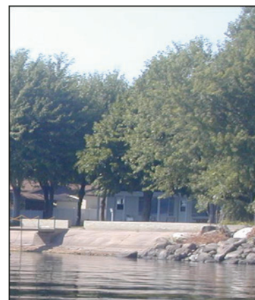
Photo 26: Utilisation du faite du mur pour déterminer la ligne des hautes eaux
