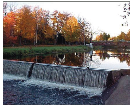
Photo 25: Ligne des hautes eaux, en présence d'un ouvrage de retenue, correspond à la cote maximale d'exploitation
