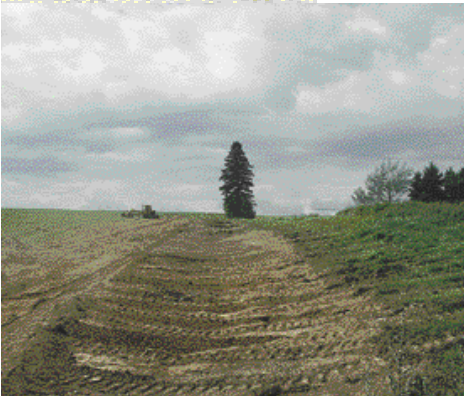
Aménagement d'une voie d'eau engazonnée
