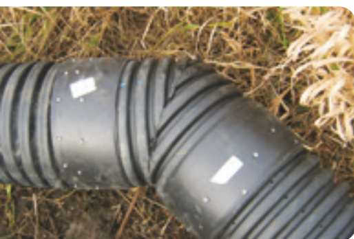
Figure 48 : Solidification du joint à 45°
