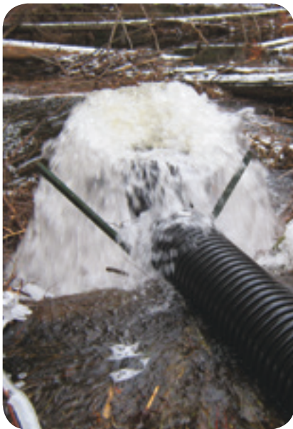
Figures 61 et 62 : Reconstruction du barrage en novembre et activation système
