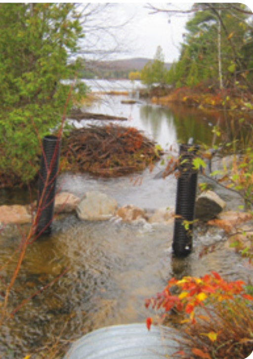
Figure 63 : Pré-barrage et système de contrôle de niveau d'eau double
