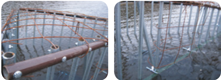
Figures 56 et 57 : Mise en place du grillage au-dessus de la cage et du bec
