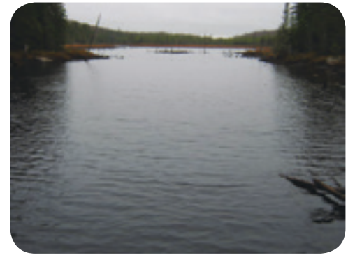
Figure 28. Bassin d'eau retenu par un vieux barrage, le lac Whissell
