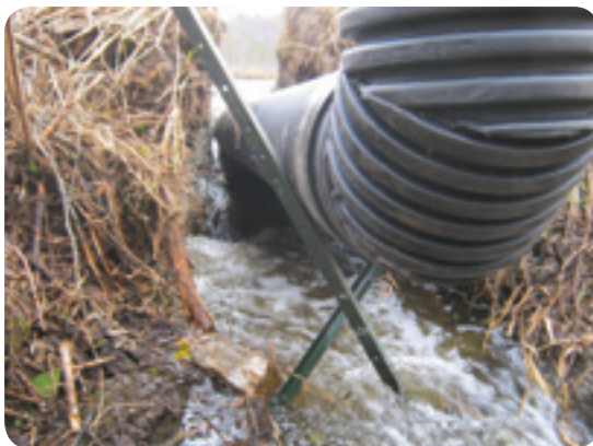
Figure 52 : Positionnement du drain à travers le barrage
