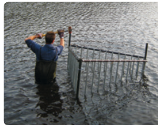
Figure 51 : Mise en place de la cage
