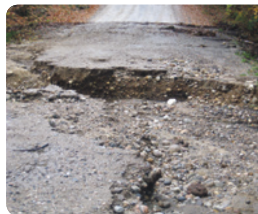
Figure 7. Rupture du réseau routier à Duhamel le 19 octobre 2011 (Source : Corine Dubois)
