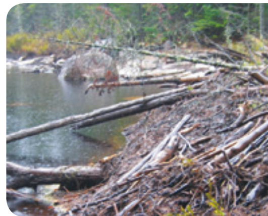
Figures 34 et 35 : Réduction du niveau d'eau et de la pression exercée sur le barrage
