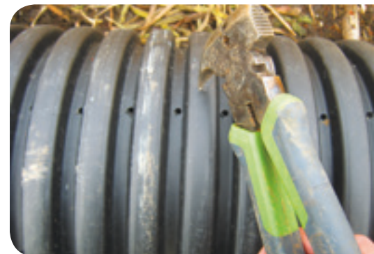
Figure 44 : Perforation des trappes à air
