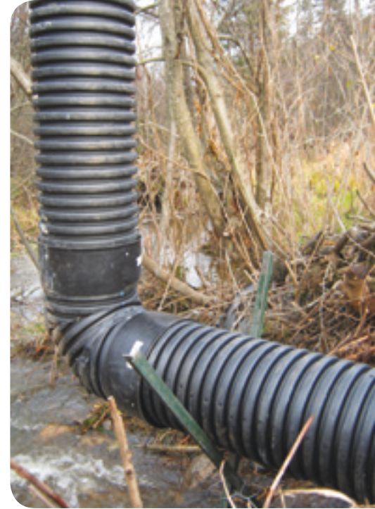
Figure 60 : Présentation d'une sortie d'eau non activée (en aval du barrage)
