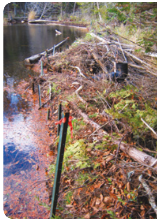
Figure 64: Renforcement d'un barrage de castor
