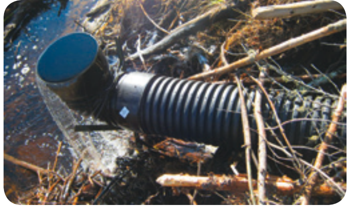
Figure 40 : Le contrôle de décharge
