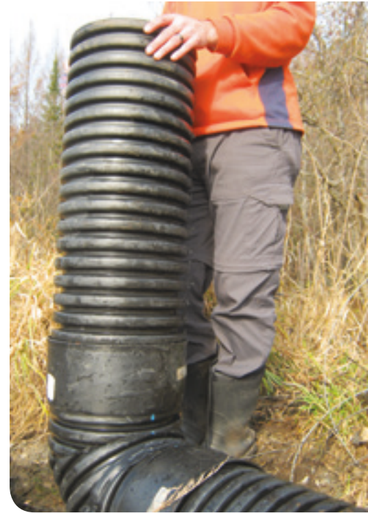
Figure 42 : Mise en place de la sortie d'eau
