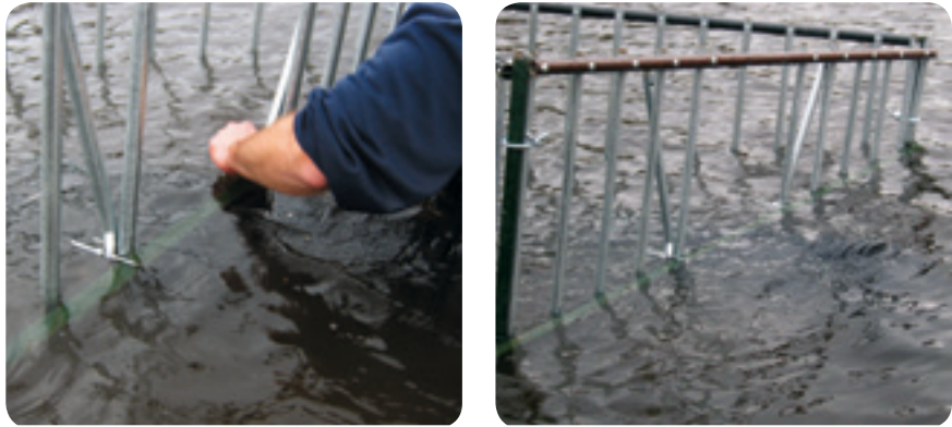
Figures 54 et 55 : Mise en place de la barre horizontale
