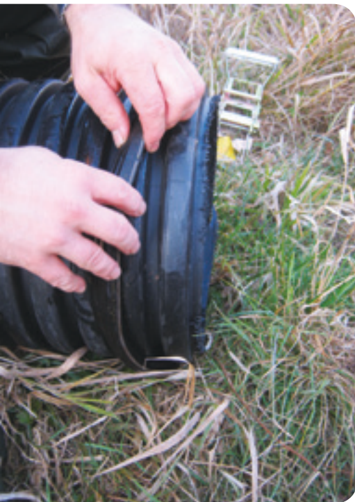
Figure 41 : Mise en place d'un collet étanche à l'extrémité d'un drain non-perforé rigide
