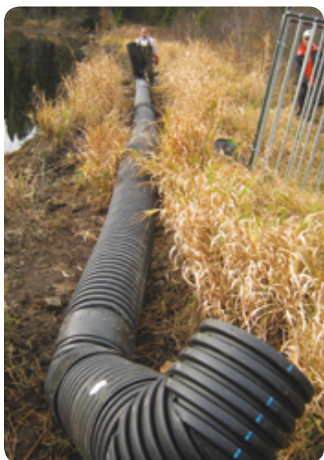
Figure 49 : Assemblage complet d'un système de drains
