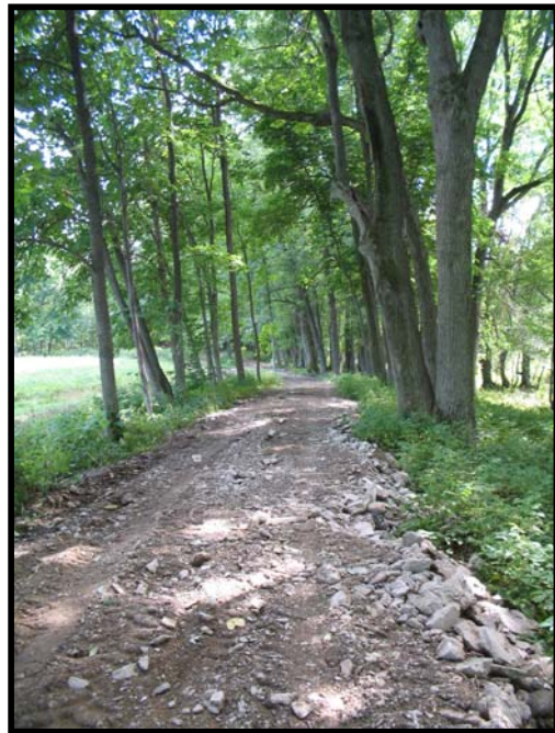
Fig. : 06-08 Chemin présentement en construction Photo Alexandre Guérin août 2005
