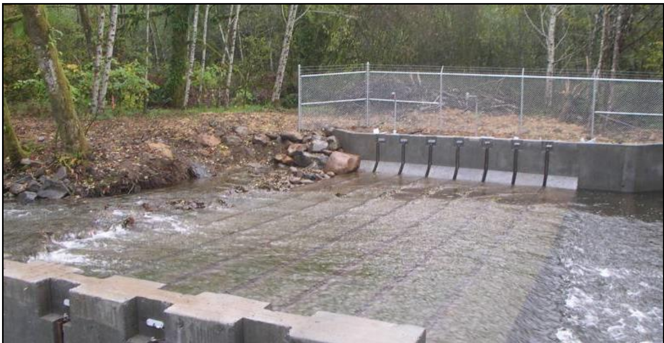
Figure 5.4 Barrière électrique du centre Abernathy, Washington (source photo : Smith-Root Inc.).
