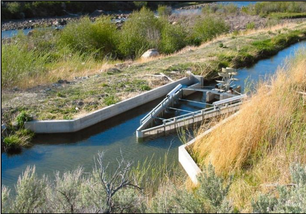
Figure 5.1 Écran à poissons comme moyen d'exclusion des espèces aquatiques envahissantes, installé sur le ruisseau du lac Bull (Wyoming, U.S. Fish and Wildlife Service, États-Unis).
