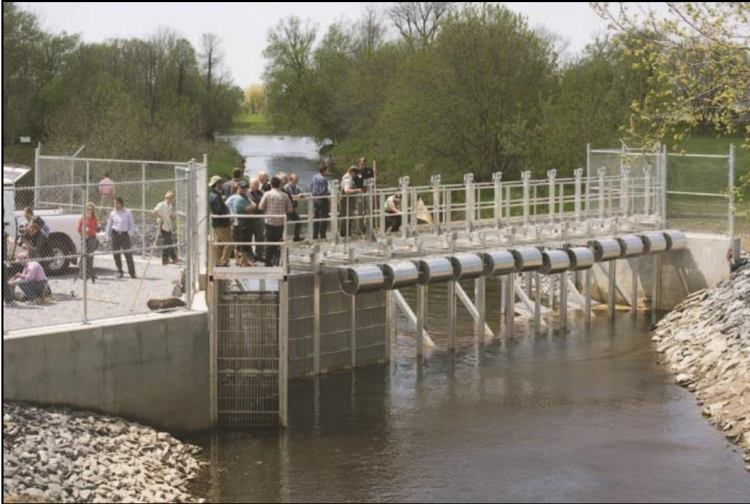
Figure 5.2 Barrière de capture du ruisseau Morpion (source photo : Journal le Saint-Armand , juin 2014).
