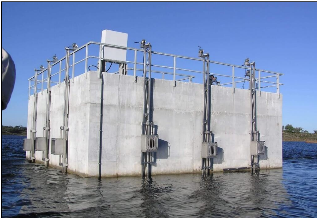
Figure 5.5 Système d'évitement acoustique sur installations de captation d'eau aux abords d'une centrale nucléaire (lieu non précisé, source photo : Ovivo Inc.).
