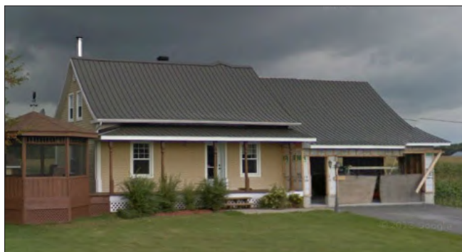
Photo 6.58 Maison patrimoniale située au 43, rang Saint-Joseph, construite vers 1850 Street View, 2013
