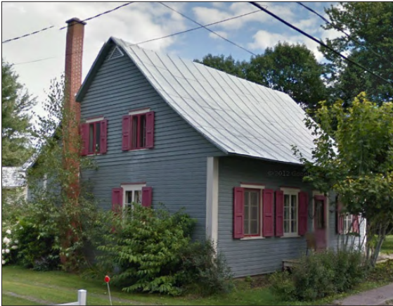
Photo 6.64 Maison patrimoniale, située au 228, rang de l'Île à Notre-Dame-de-Pierreville. Construite vers 1800 Street View, 2013
