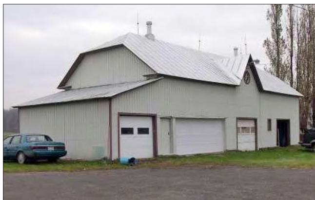
Photo 6.86 Écurie de la Fabrique, construite en 1898 Conseil du patrimoine religieux du Québec 2003a
