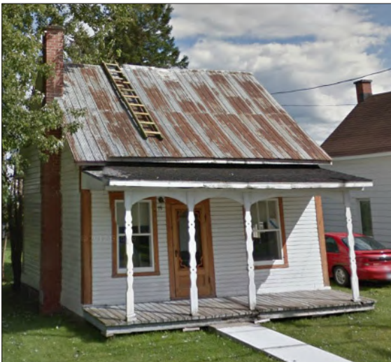
Photo 6.66 Maison patrimoniale située au 19, rue Principale, à Notre-Dame-de-Pierreville. Construite vers 1875 Street View, 2013
