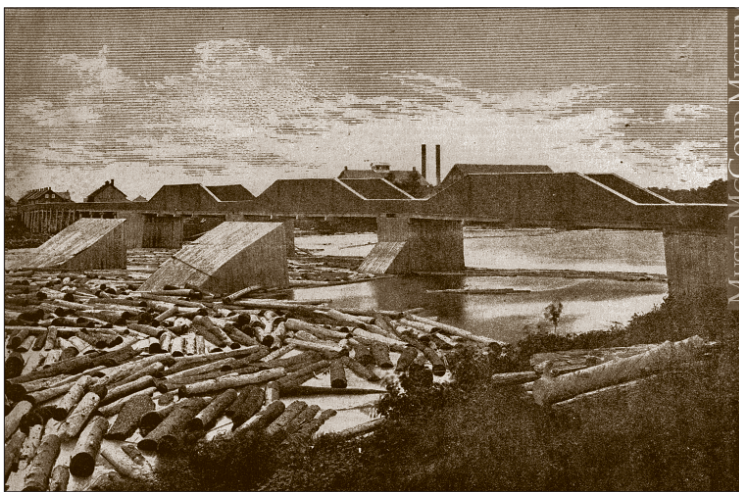
Photo 6.62 Pont et estacades sur le chenal Tardif, à Notre-Dame-de-Pierreville, vers 1871 Musée McCord, MP-0000.1137.1
