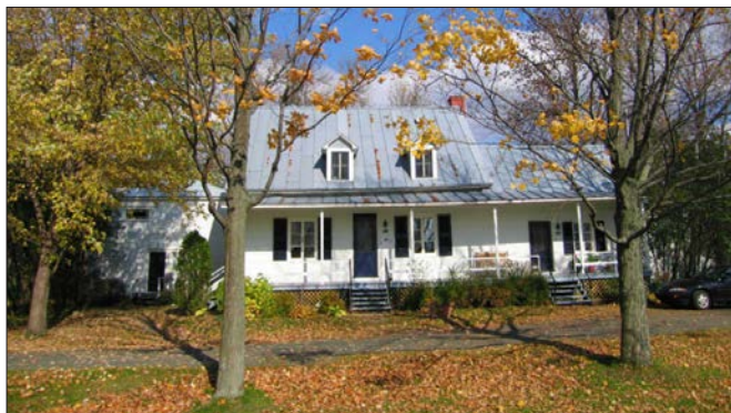
Photo 6.25 Atelier et maison Rodolphe-Duguay, situés aux 185-195, rang Saint-Alexis. La maison fut construite en 1854 et l'atelier en 1927 Répertoire du patrimoine culturel du Québec, Ministère de la Culture et des Communications, Jean-François Rodrigue, 2006
