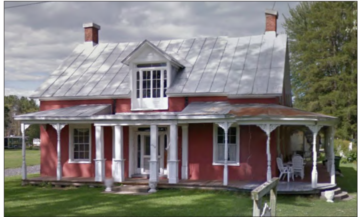
Photo 6.65 Maison patrimoniale située au 252, rang de l'Île à Notre-Dame-de-Pierreville. Construite vers 1865 Street View, 2013
