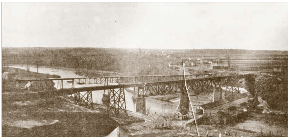
Photo 6.108 Aperçu du pont couvert construit en 1882 et de deux ponts ferroviaires (sans date) Tiré de s.a. 1966, p. 101
