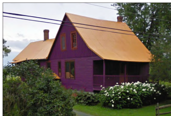
Photo 6.112 Maison patrimoniale située au 830, 11 e rang, construite entre 1898 et 1905 Street View 2013
