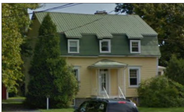
Photo 6.103 Maison patrimoniale située au 1150, rue Principale, construite vers 1880 Street View 2013
