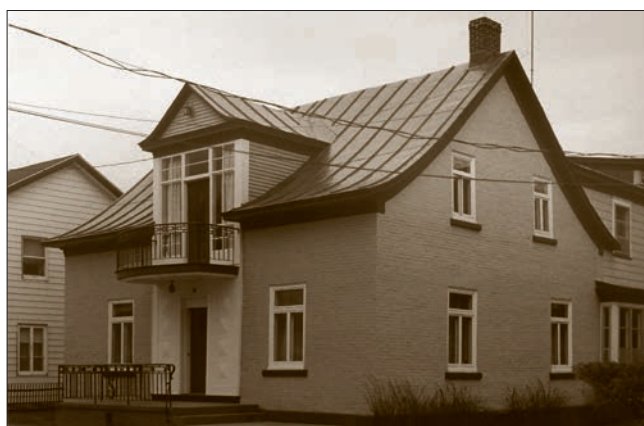
Photo 6.60 Maison patrimoniale située au 48, rue Maurault, construite vers 1860 Archives du Séminaire de Nicolet, F212/E3/99
