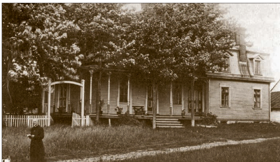
Photo 6.83 Presbytère de Saint-Elphège, construit entre 1887 et 1889 tiré de Grandmont 1986, p. 203
