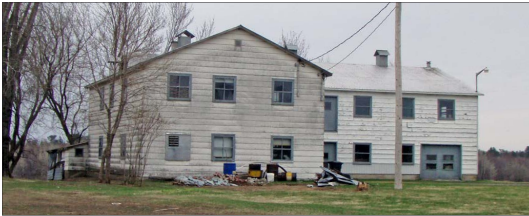
Photo 6.12 Bâtiment de la tannerie Matte ou tannerie Beaudet. 17, rang Grande-Terre. Archéotec inc. NYP12-PV1-100
