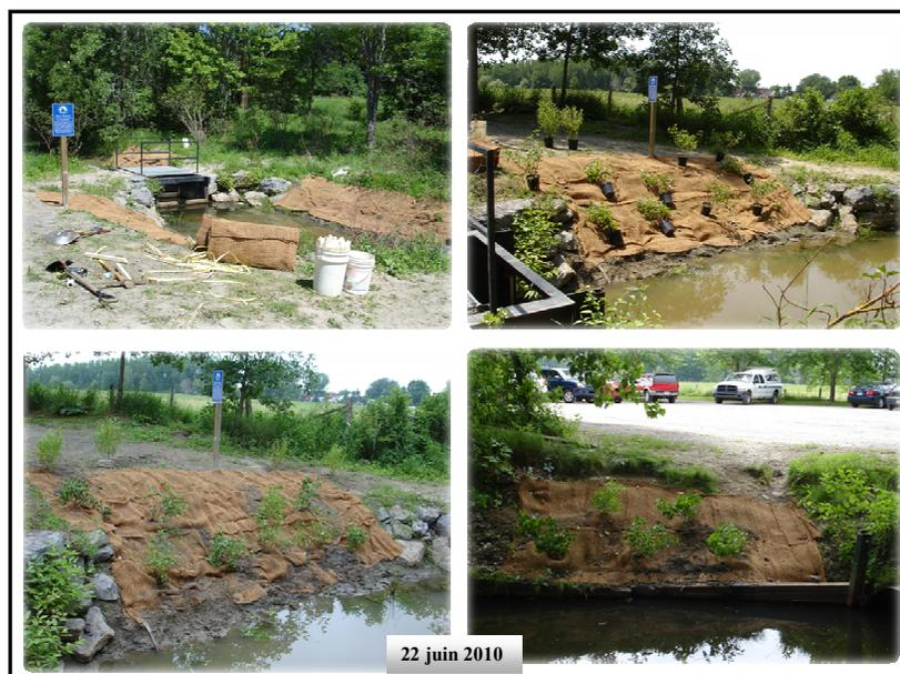
Photo 7. Travaux de revégétalisation réalisés en juin 2010 et 2011 sur les berges bordant la voie migratoire et en amont du ponceau (photo en bas à droite) au marais de l'Île du Milieu.
