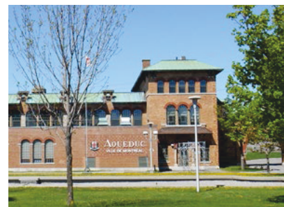
L'USINE ATWATER QUI PROCÈDE À LA FILTRATION DES EAUX DU SAINT-LAURENT ET APPROVISIONNE EN EAU POTABLE DES MILLIERS DE MONTRÉALAIS, PHOTO : JEAN GAGNON / WIKIMEDIA COMMONS
