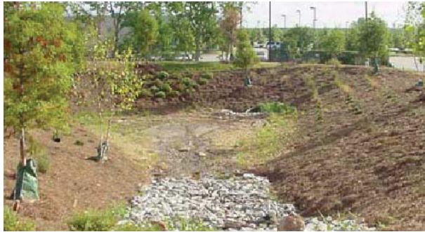
Bassin sec de rétention à la gare chevauchant les arrondissements de Saint-Léonard et de Montréal-Nord
