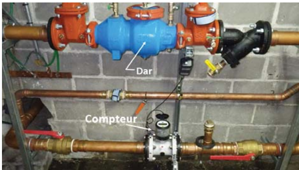
Exemple d'installation d'un compteur magnétique 3" avec Dar
