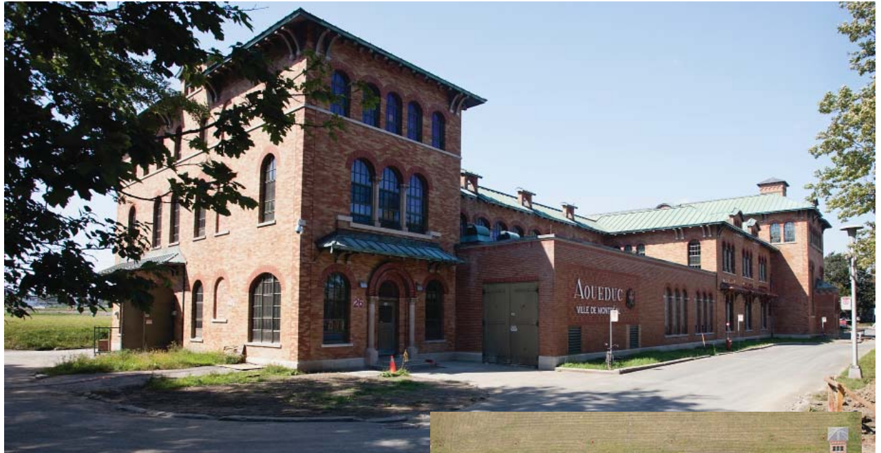
Usine de production d'eau potable Atwater
