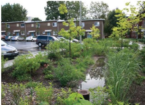
Bassin de biorétention au stationnement des Habitations Jeanne-Mance dans l'arrondissement de Ville-Marie
