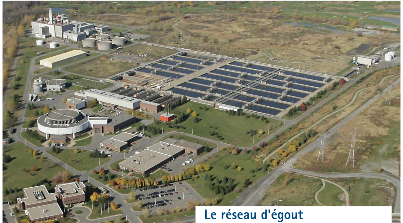
Station d'épuration des eaux usées Jean-R. Marcotte
