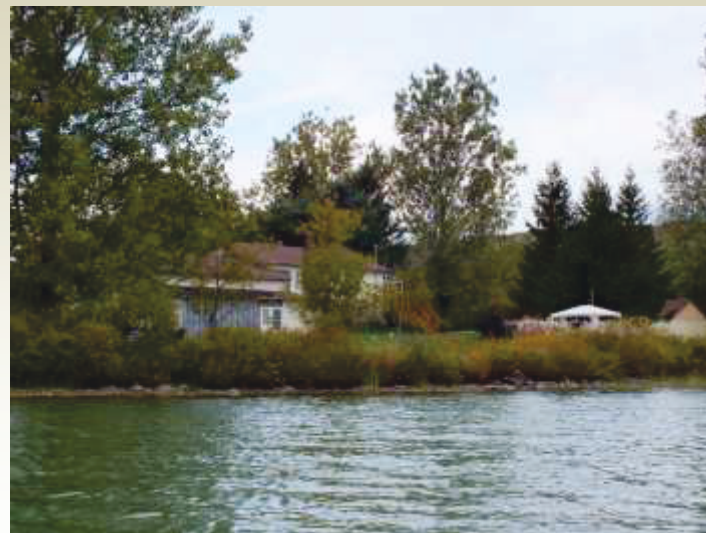
Figure 4- 51 : Enrochement masqué par la végétation
