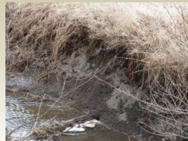
Figure 4- 45 : Érosion à la sortie du ponceau de la rue Desjardins dans le ruisseau Paquin
