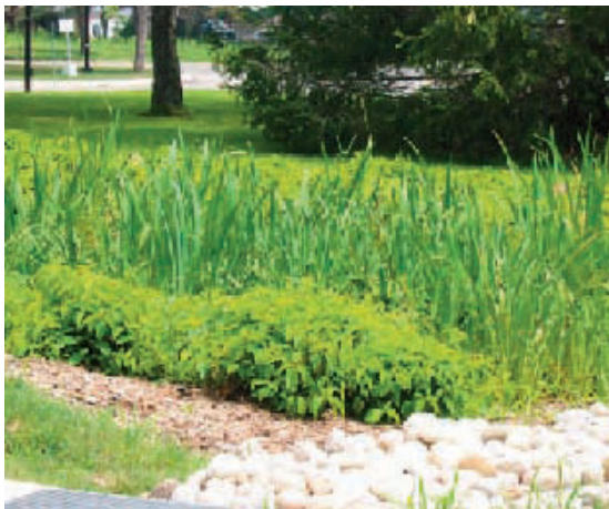
Photo 5. Aire de biorétention adjacent à un stationnement. DRAFT, 2007. Ville de Toronto
