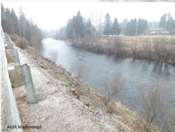
Figure 3.1.9 : Site du glissement de terrain réaménagé. En contrebas, la rivière Mastigouche
