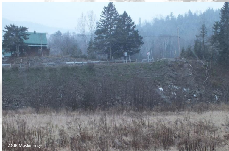
Figure 3.1.7 : Site du glissement de terrain de 2011-2012 le long de la rivière Mastigouche
