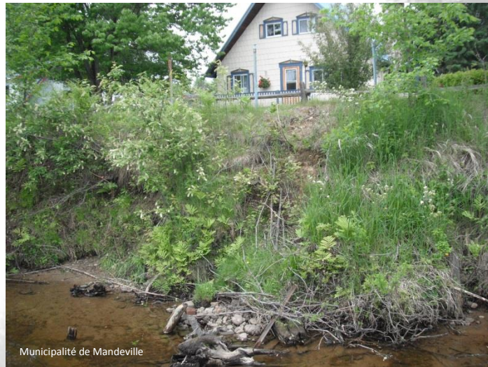
Figure 3.5.20 : Berge érodée sur la rive opposée au débarcadère public, une cinquantaine de mètres en aval.
