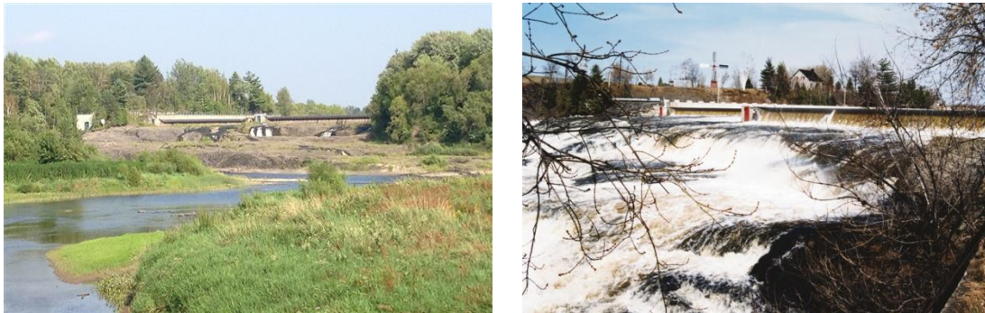
Photo 12 : Photographie du barrage hydroélectrique à Sainte-Brigitte-des-Saults
