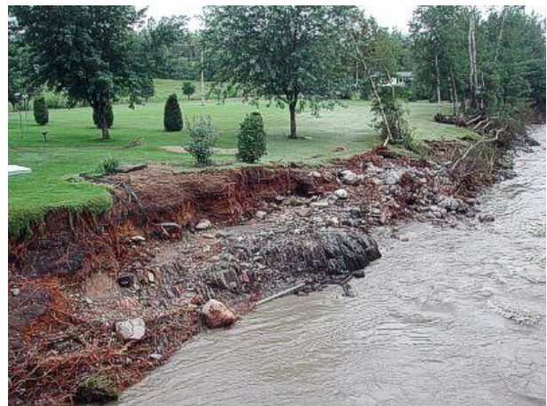
Photo 7 : Érosion des berges par la rivière des Pins, Warwick
