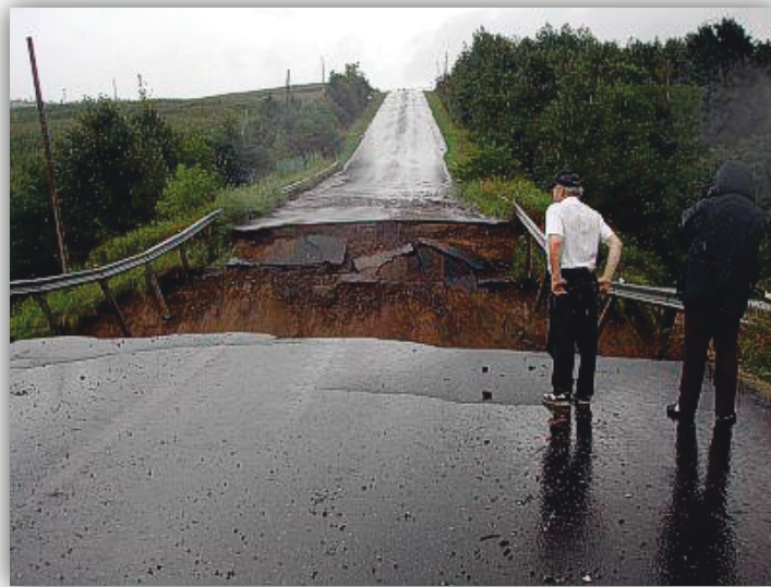
Photo 11 : Voie de communication sectionnée par le ruisseau Pouliot (Tingwick) (Source : Ressources Naturelles Canada, 2003)
