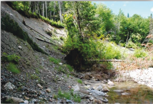
Photo 3 : Érosion de berges du ruisseau Gobeil
