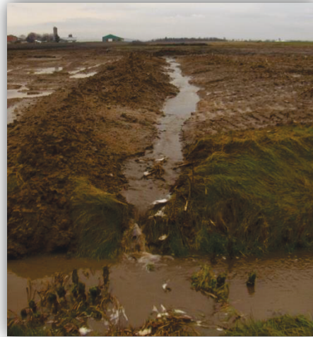
Photo 4 : Érosion en nappe et érosion des sols dans un fossé de drainage
