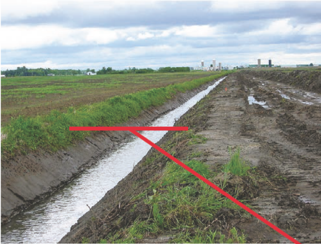
Travaux de nettoyage du cours d'eau Branche 52 de la rivière Schibouette à Saint-Liboire
