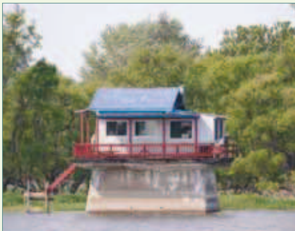
Ce chalet s'est construit sur les anciennes fondations d'une aide à la navigation dans le Grand Chenal.
