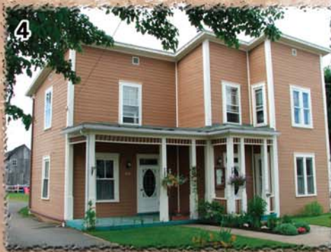
4 Saint-Étienne-des-Grès Maison à toit plat
