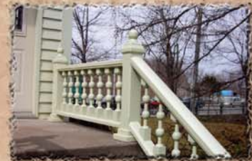
Garde-corps en bois
