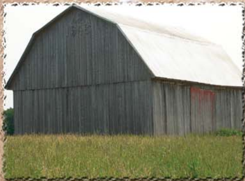
Grange située à Sainte-Ursule recouverte d'un toit à versants dit "brisés". Ce type de bâtiment est fréquent dans la MRC.
