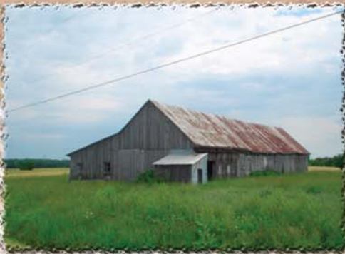
Située à Saint-Sévère , grange-étable à deux versants droits.
