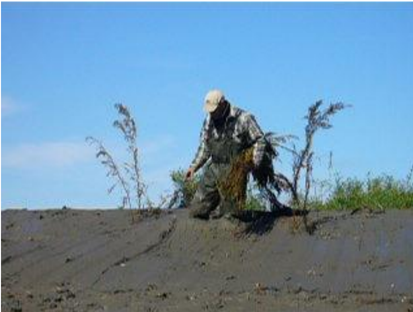
Plantation dans le haut des talus
