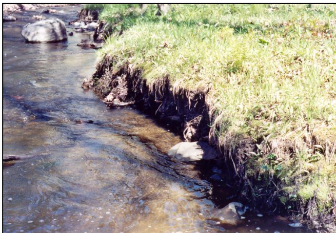
Érosion de la rive par minage
