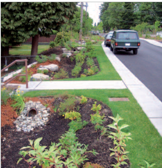
Figure 36 : Noue avec biorétention.
