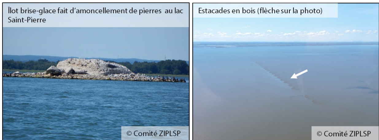
Figure 8. Îlot brise-glace (photo de gauche) et estacades en bois (photo de droite)
