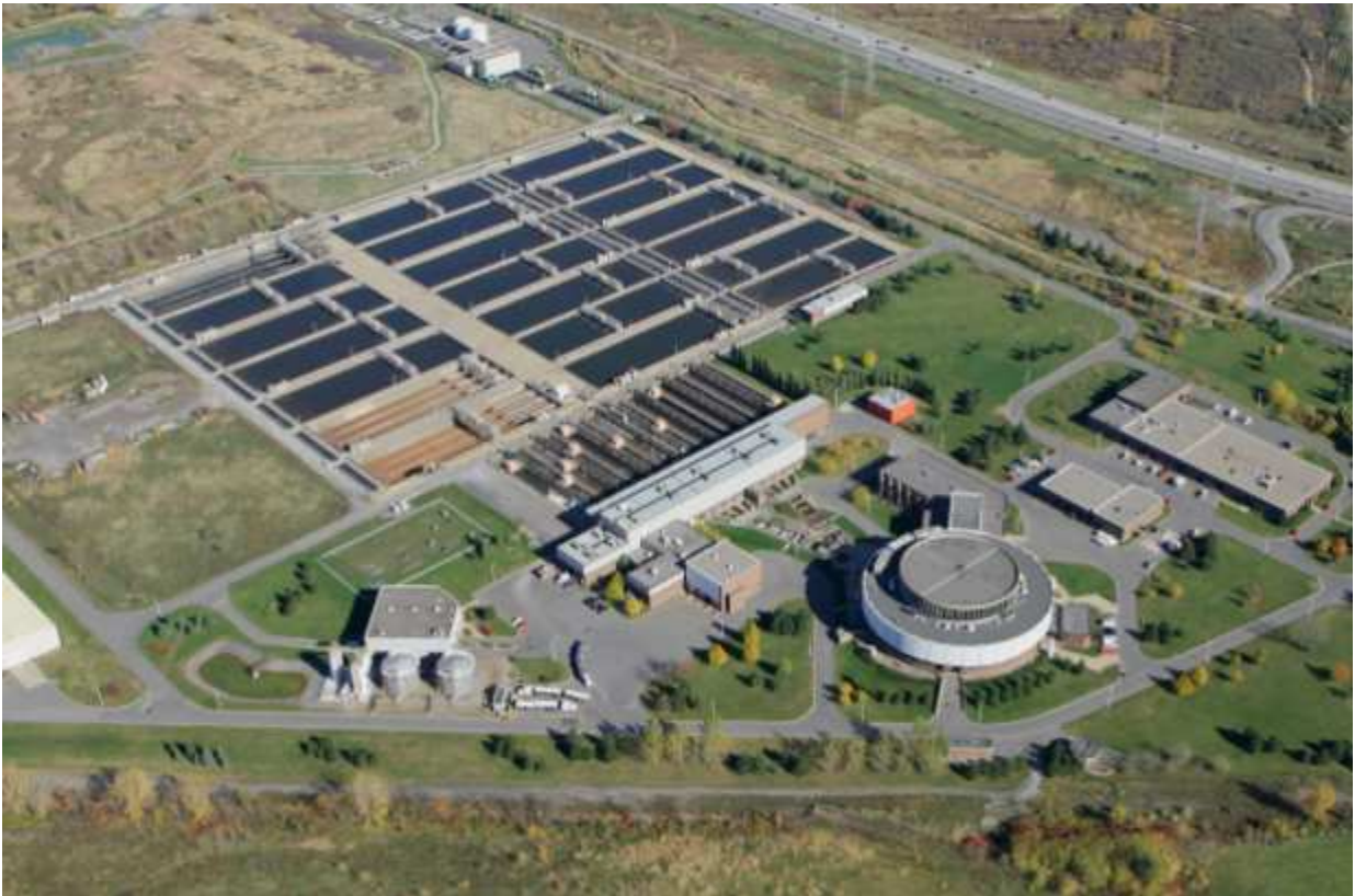
Figure 2 – Station d'épuration de la ville de Montréal
