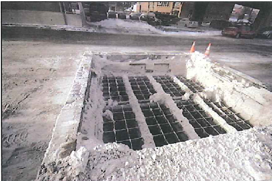
Chute à neige
