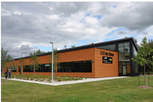
Bâtiment du CFER des Chênes en voie d'être accrédité LEED
