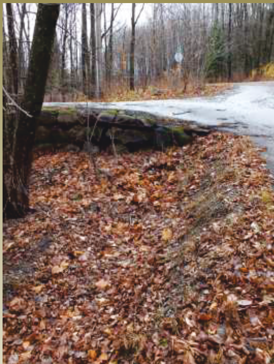
Figure 3- 33 : Fossé obstrué par une entrée de stationnement
