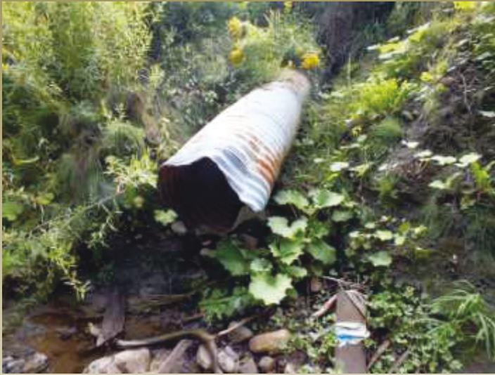
Figure 3- 30 : Conduite mise à nu par l'érosion en zone industrielle
