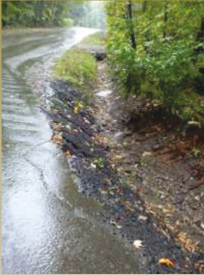
Figure 3- 51 : La forte pente entraîne l'érosion des fossés et des apports de sédiments au lac
