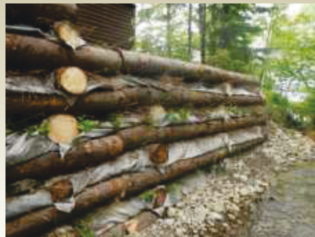
C. La berge a été stabilisée ; la végétation recouvrira peu à peu les rondins
