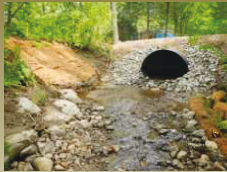
A. Ponceau remplacé
