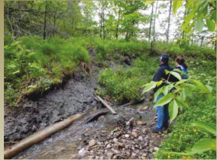
Figure 3- 31 : Ancienne conduite d'effluent de la station d'épuration découverte par l'érosion après une forte pluie
