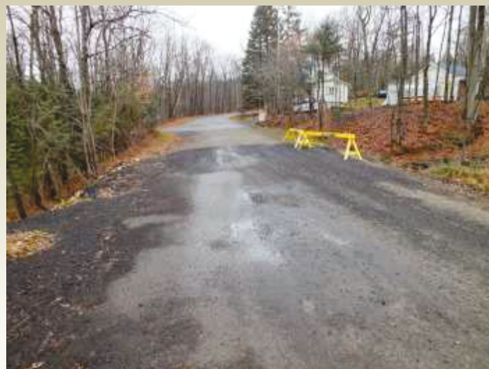
Figure 3- 36 : Route en haut du ponceau régulièrement dégradée par les inondations et le ruissellement
