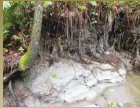
B. Berge érodée en sortie de ponceau
