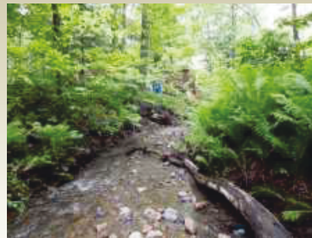
D. Vue d'ensemble avant travaux
