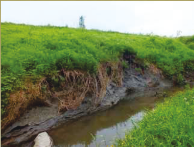
Figure 3- 28 : berges du ruisseau Comeau dans la zone industrielle
