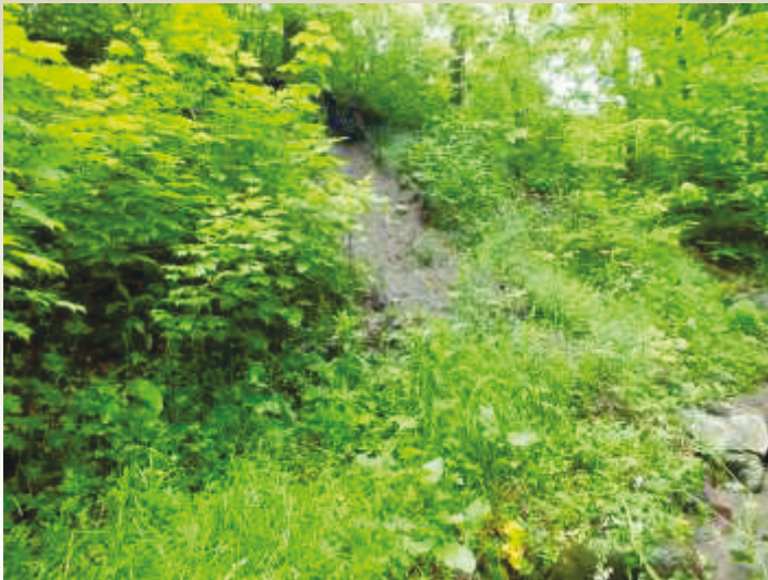
Figure 3- 29 : Berge érodée Terrasse Comeau
