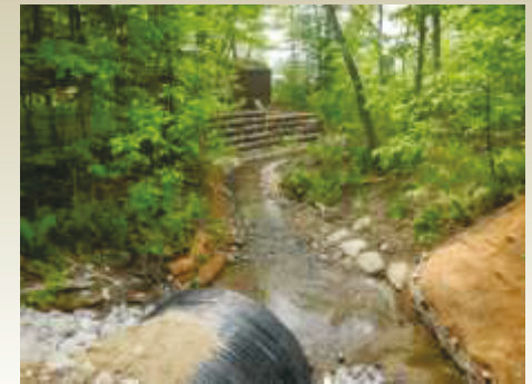
D. Les techniques de génie végétal et l'empierrement permettent de corriger le trajet de l'eau et de limiter l'érosion.
