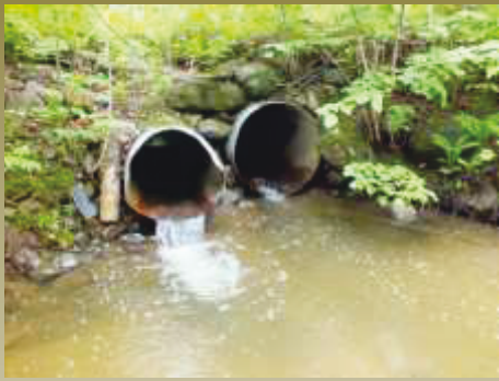
A. Ponceau avant travaux
