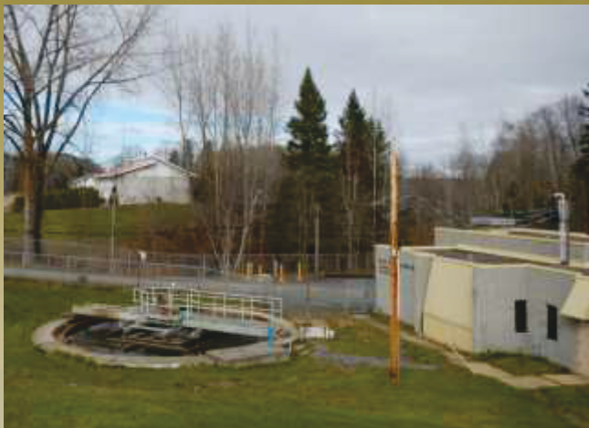
Figure 3- 41 : La station d'épuration de Ville Saint-Gabriel
