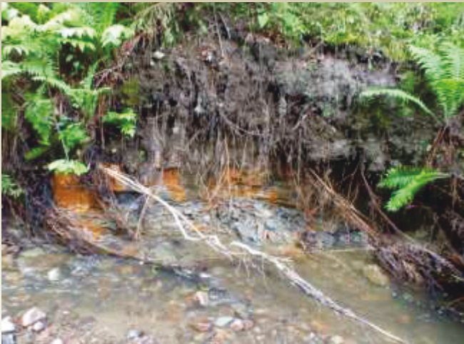
Figure 3- 27 : Berge du ruisseau Comeau près de son exutoire au lac Maskinongé : strates d'argile bleue sous une couche de loam argileux
