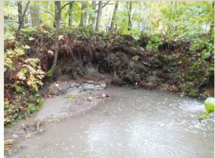
Figure 3- 32 : Érosion active après le dernier ponceau avant l'embouchure du ruisseau Comeau
