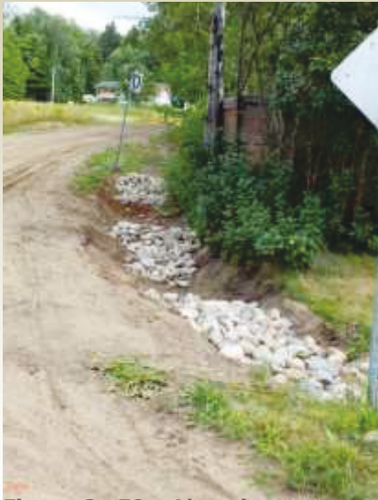
Figure 3- 50 : L'empierrement et l'aménagement de seuils peut résoudre ce problème
