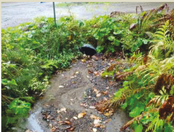
Figure 3- 35 : Fossé obstrué par les sédiments
