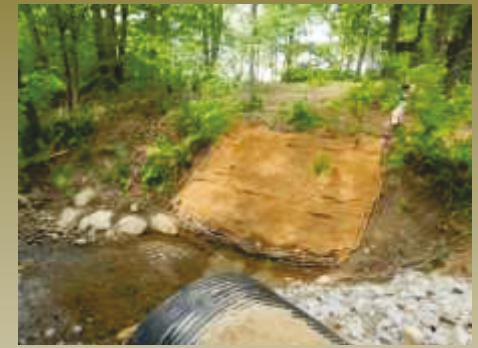
B. La pente a été corrigée et la berge stabilisée
