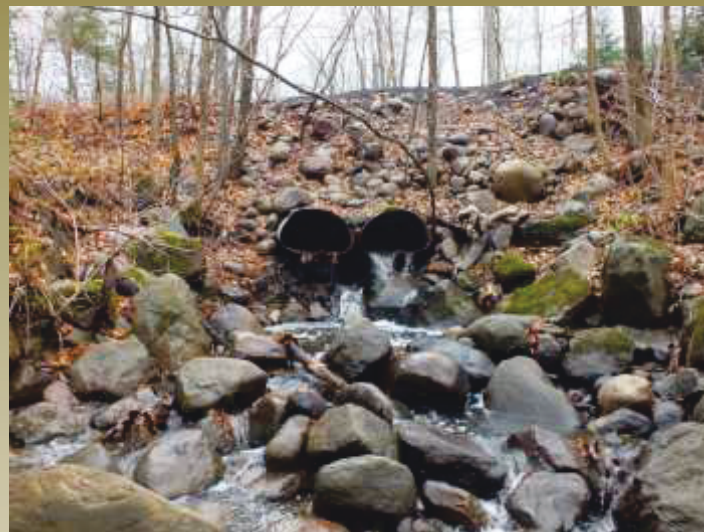
Figure 3- 34 : Ponceau écrasé par le poids de l'enrochement et sous-dimensionné
