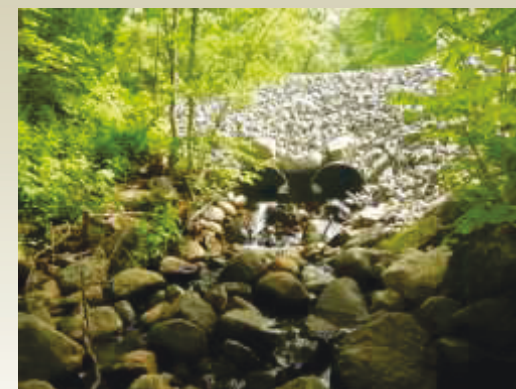
Figure 3- 48 : Ponceau de la Terrasse Comeau dont l'empierrement a été refait suite au débordement du ruisseau
