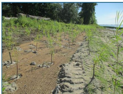
génie végétal. Ainsi, les pentes ont été retravaillées puis recouvertes d'une toile de fibre de coco, retenue par des pieux, ce qui permet de soutenir les berges. Une clé d'enrochement a été installée au bas de la berge pour contrer l'effet des vagues. Des saules ont été plantés sur l'ensemble de la berge afin que se développe un couvert végétal et racinaire solide qui maintiendra le sol en place et permettra l'établissement d'une bande riveraine végétalisée.
