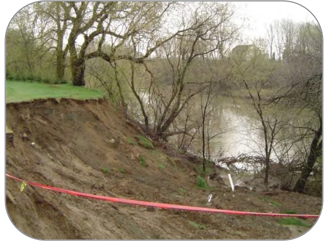
Glissement de terrain, sur les berges de la rivière du Loup, ayant eu lieu au printemps 2006 dans la ville de Louiseville.
