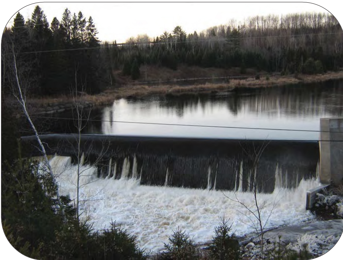
Barrage Innergex situé en amont de la Chute à Magnan sur la rivière du Loup dans la municipalité de Saint-Paulin. Photo prise en novembre 2008.
