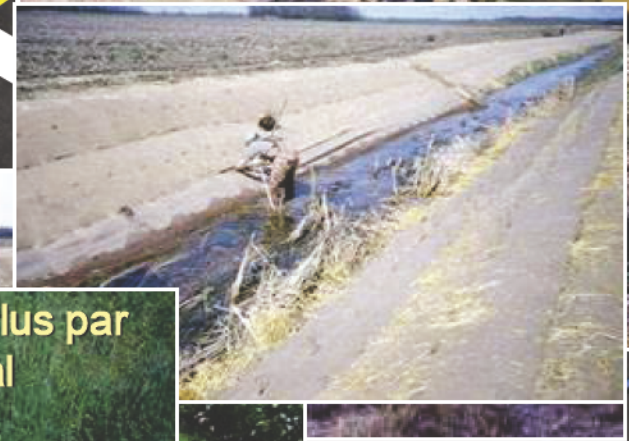
Réaménagement des talus
