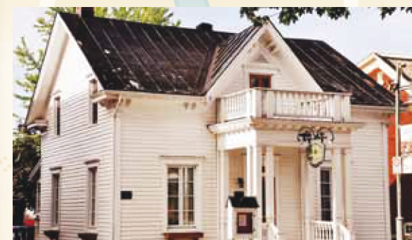
1. Maison du Commis-Voyageur 115, avenue Saint-Laurent Maison à toit à 2 versants droits, d'inspiration néo-gothique, construite vers 1902. (L.L.)
