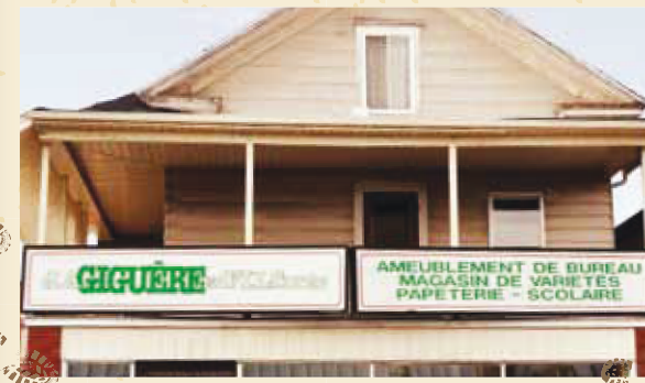
13. Maison J.A. Giguère 331, avenue Saint-Laurent Le magasin général a été construit par Joseph-Augustin Giguère. Ce magasin abritait un magasin à rayons et une imprimerie. J.A. Giguère a tenu la barre de son commerce jusqu'en 1949, année de son décès. Ce centre commercial a été transformé à plusieurs reprises. La place de commerce de monsieur Giguère a été antérieurement occupée par monsieur Wellie Gagnon, marchand et exportateur de grain et maire de Louiseville entre 1923 et 1925. (S.H.G.L.)
