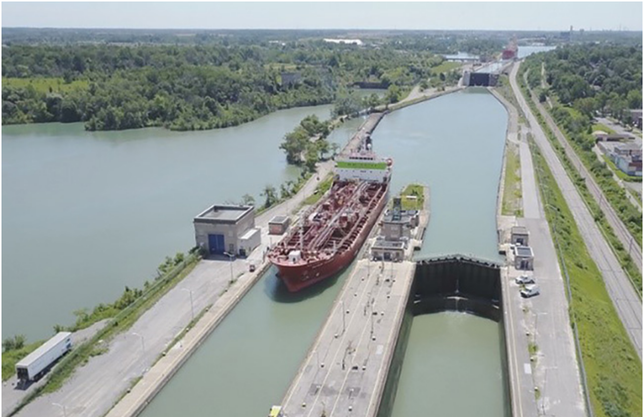
Photo : Corporation de Gestion de la Voie Maritime du Saint-Laurent
