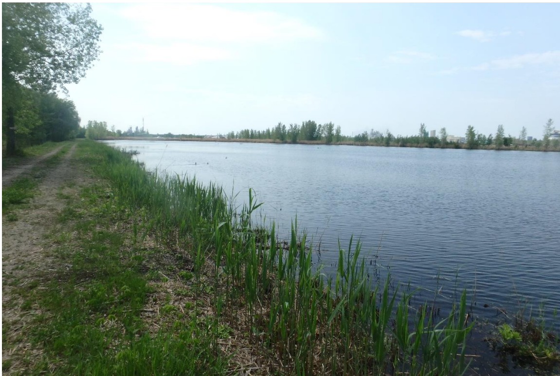
Photo 8 Bassins de sédimentation
