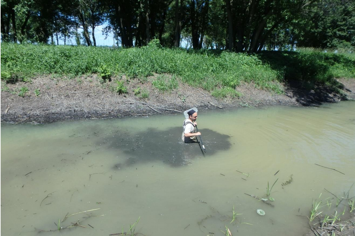
Photo 4 Envasement des canaux aménagés près de la rivière Marguerite. Bien qu'il n'y est environ que 60 cm d'eau, le pêcheur dans cette photo est enseveli jusqu'à la taille.
