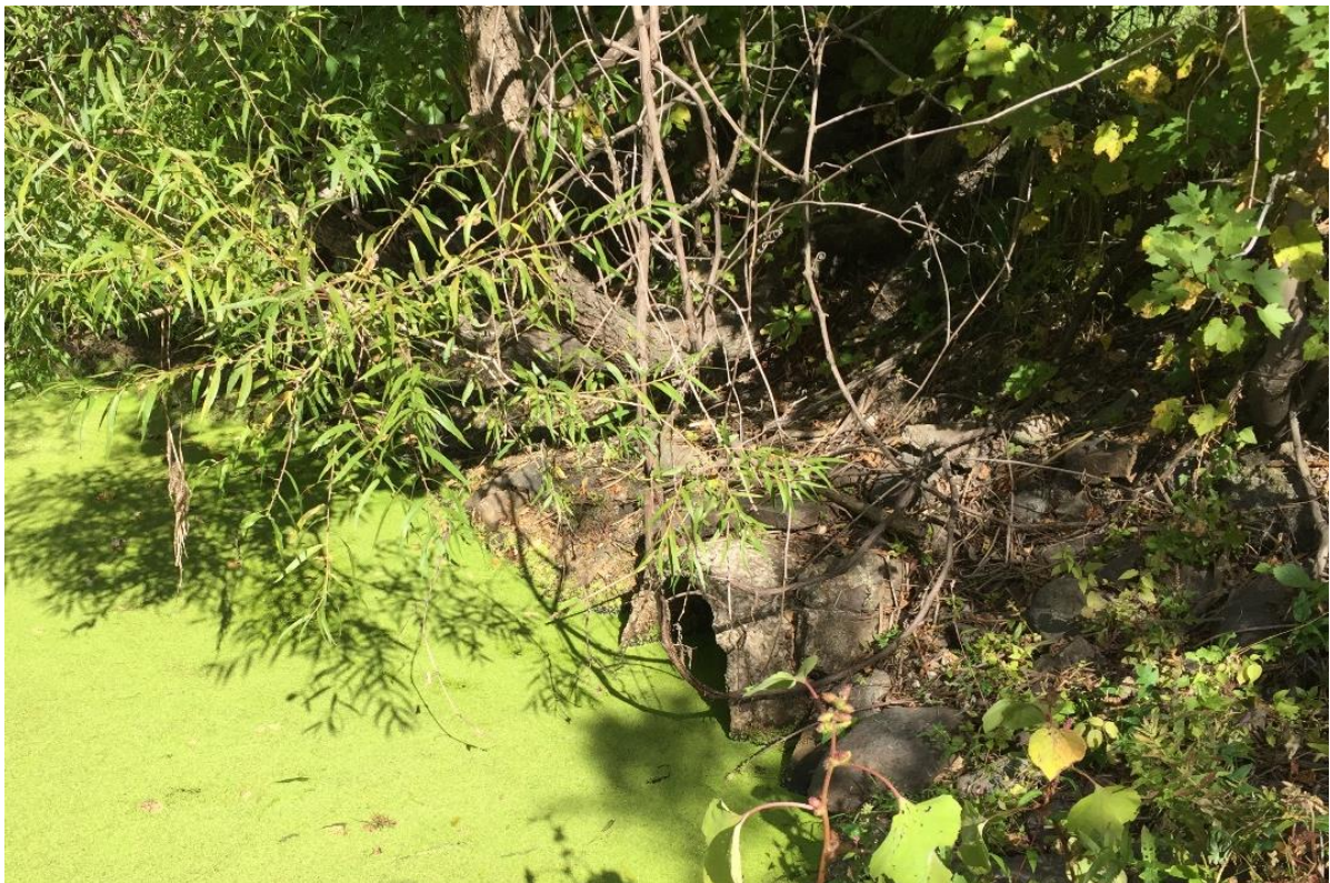
Photo 6 Ponceau connectant la rivière Godefroy au méandre dans la section aval de la rivière.
