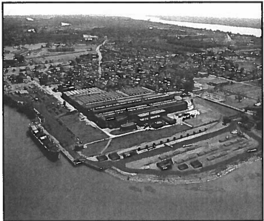
TERMINAL MARITIME SOREL-TRACY VUE GÉNÉRALE DES INSTALLATIONS EXISTANTES
