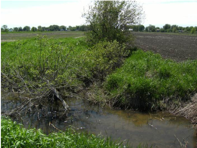
FIGURE 9 SORTIE DE FOSSÉ VÉGÉTALISÉE
