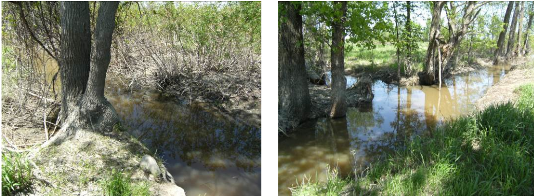
FIGURE 16 SORTIES DE FOSSÉS OÙ LES ARBRES ONT ÉTÉ CONSERVÉS POUR RETENIR LES SÉDIMENTS
