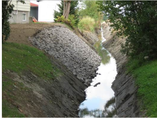
FIGURE 15 EMPIERREMENT RÉDUISANT LA SÉDIMENTATION
