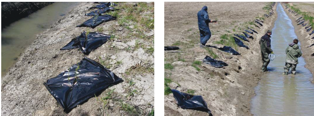
FIGURE 13 PLANTATION D'ARBUSTES AU RUISSEAU MAYER
