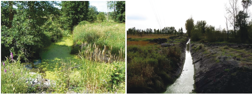
FIGURE 5 ZONES AVANT ET APRÈS LES TRAVAUX QUI ONT EU LIEU AU COURS D'EAU BÉRARD ET CES BRANCHES
