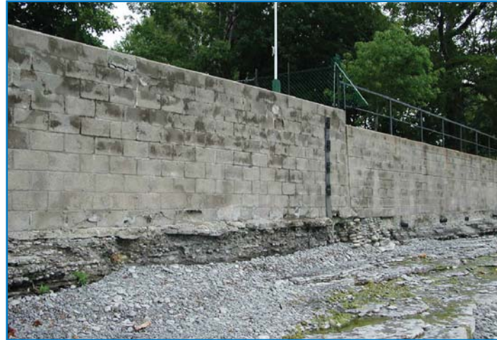
Figure C-3 : Exemple d'ouvrage de protection des rives exposé à l'affouillement en période de basses eaux
