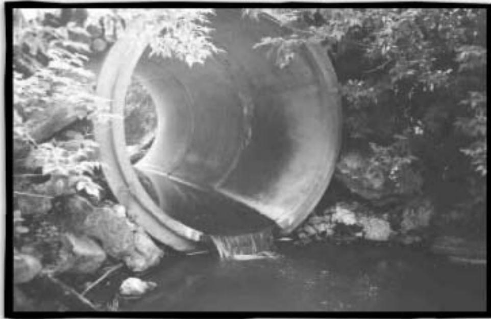
**Photo 12.** Exemple d'un ponceau installé de la mauvaise façon. Des ponceaux mal conçus, non suffisamment enfouis ou avec une pente inadéquate constituent des obstacles majeurs à la libre circulation du poisson, que ce soit pour son alimentation ou pour les activités de reproduction.
