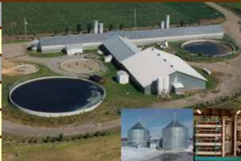
Installations de traitement des fumiers
