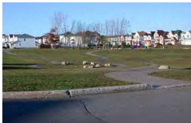
Figure 5.13 Exemple de bassin de rétention majeur.
