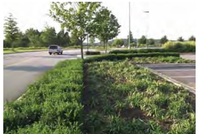
Figure 4.16 Zones de traitement pour un stationnement.
