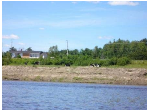
Photo 18 : Remaniement de la berge et absence de clôture
