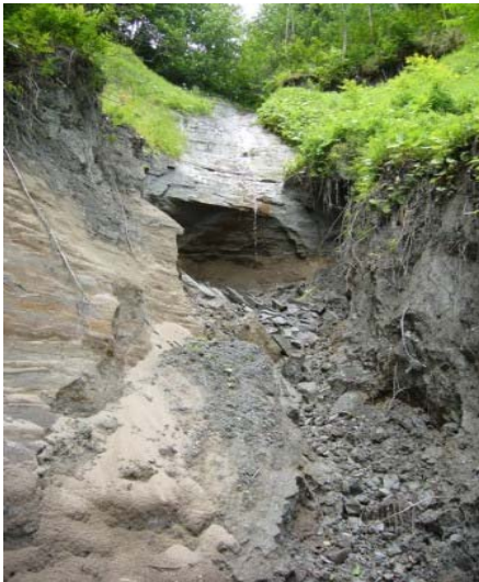
Photo 25 : Glissement de terrain argileux
