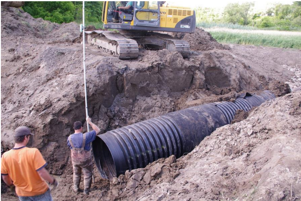
Travaux de juillet 2014. Le ponceau a été repositionné et installé plus profondément afin d'assurer une lame d'eau supérieure à 20 cm à l'intérieur de celui-ci.
