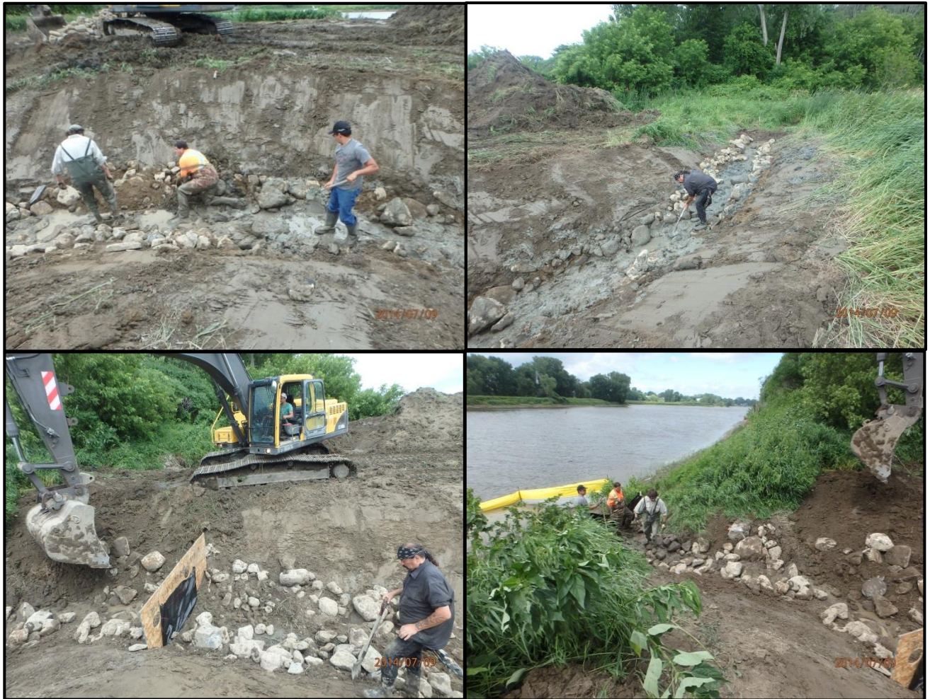
Figure 5. Photos de l'enrochement du nouveau cours d'eau prises le 9 juillet 2014.
