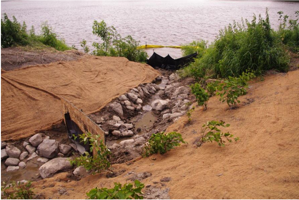
La plantation d'arbustes a complété les travaux.
