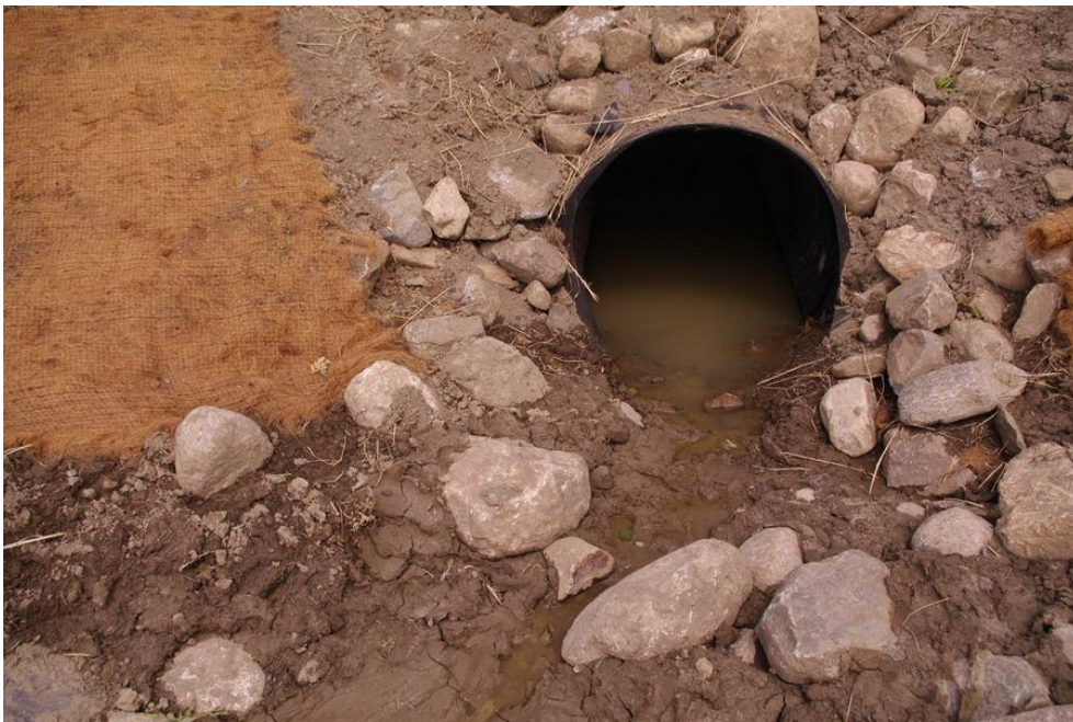
Les extrémités du ponceau ont été protégées par de l'empierrement. On remarque le volume important d'eau retenu dans le ponceau.
