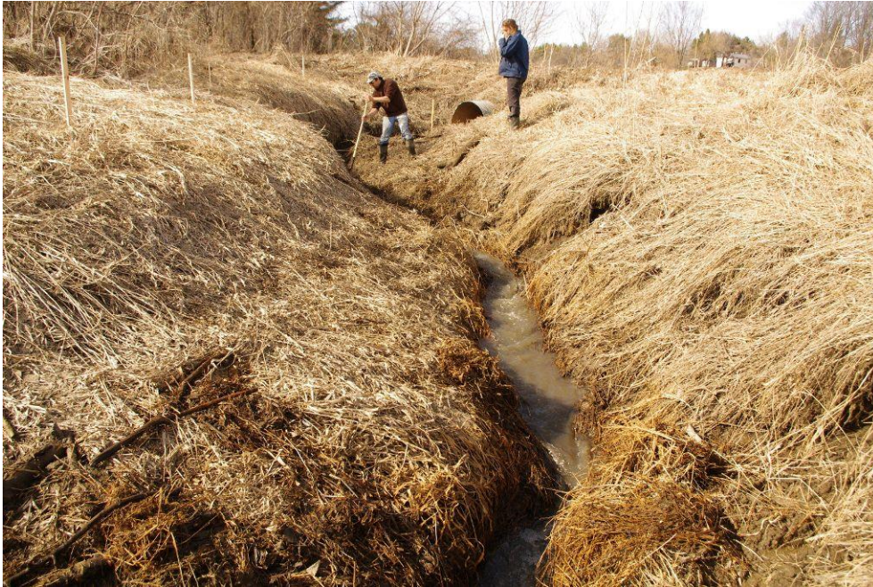
Situation de printemps 2013. La forte pente longitudinale et la lame d'eau insuffisante compromettent fréquemment la libre circulation de la perchaude vers le marais.
