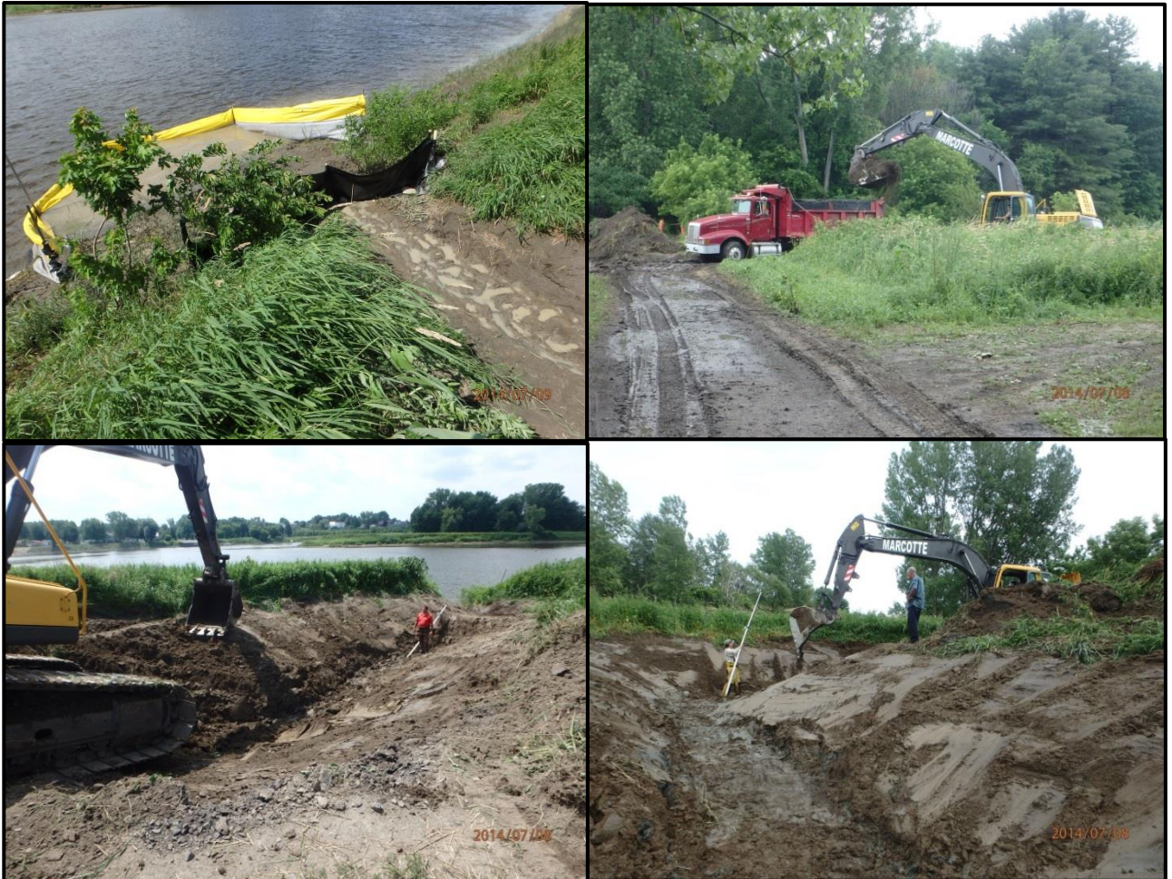
Figure 4. Photos de l'excavation du nouveau cours d'eau prises le 8 et 9 juillet 2014.
