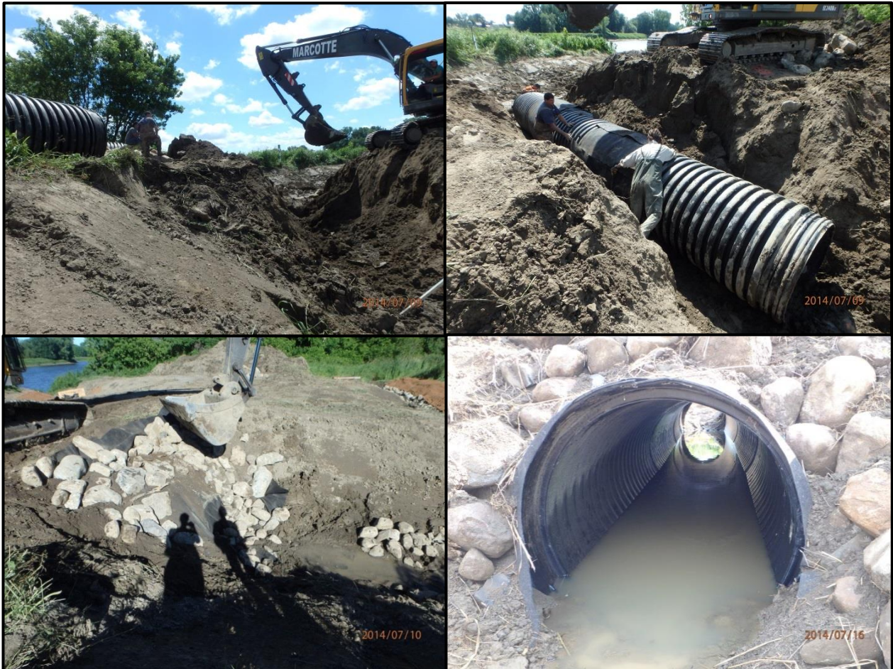
Figure 6. Photos de l'aménagement du nouveau ponceau prises les 9 et 10 juillet 2014.
