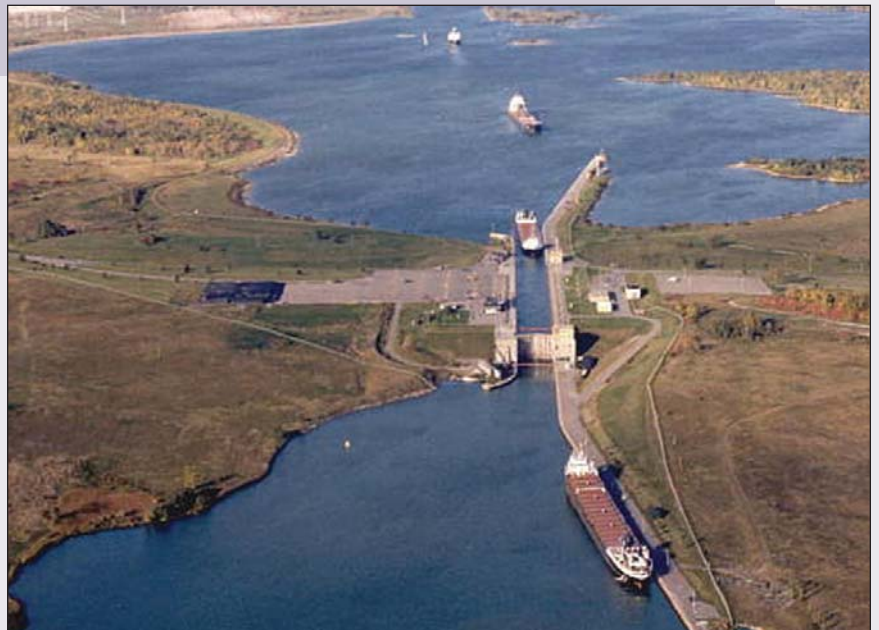
Vue aérienne de l'écluse Eisenhower Source : Saint Lawrence Seaway Development Corporation
