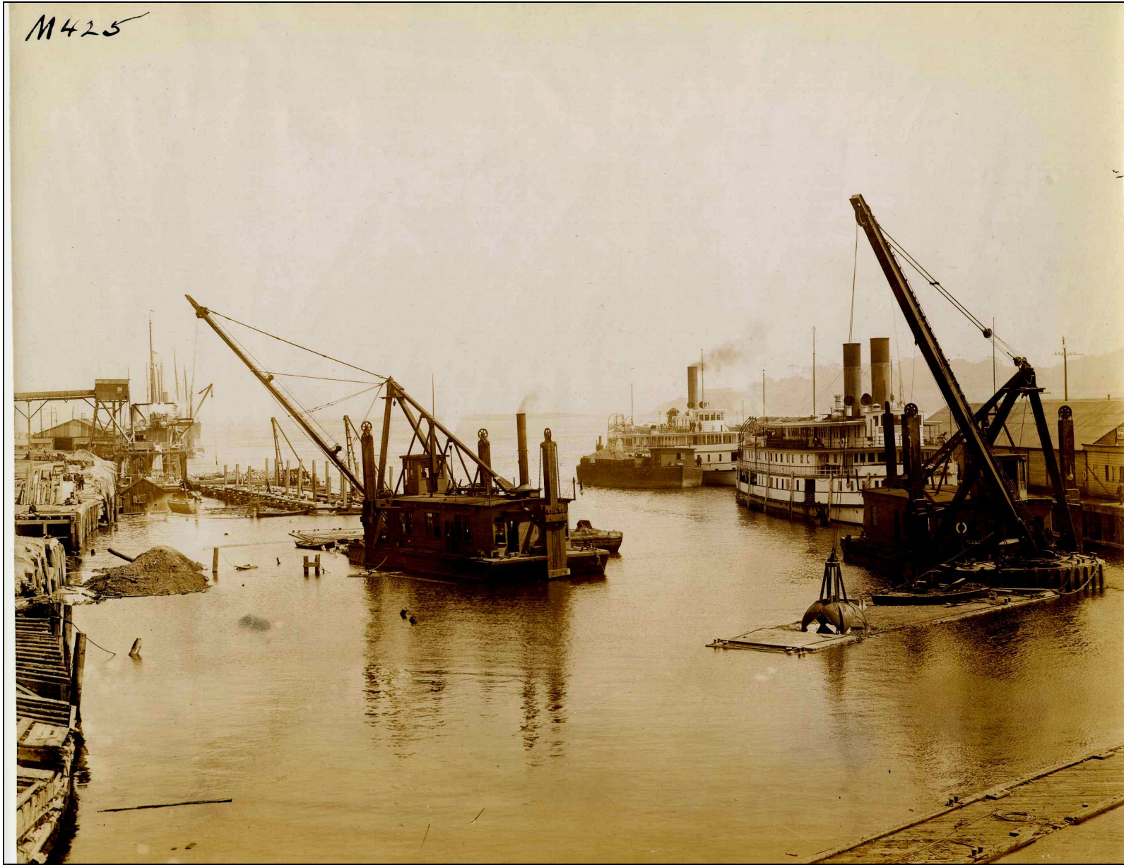
Figure A.2 : Travaux dans le chenal de navigation (1910).
