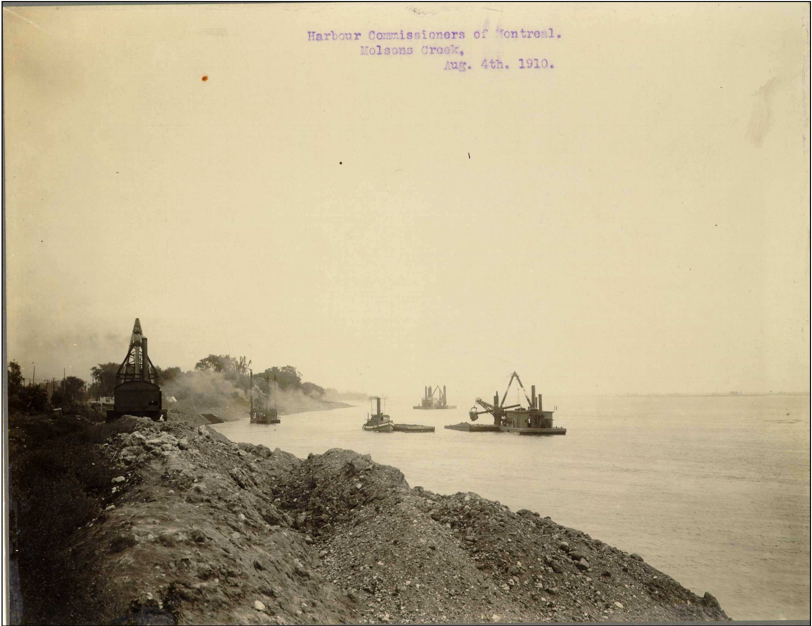
Figure A.5 : Dragage dans le port à la hauteur du Ruisseau Molson – Travaux nécessités par la construction de cale sèche (1910).
