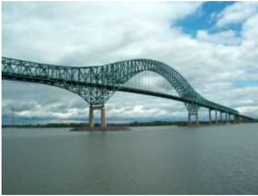
Pont Laviolette Crédit photo : François Harvey
