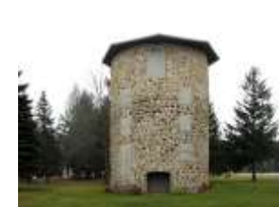
Moulin à vent de Trois-Rivières
