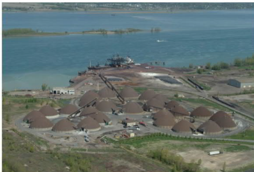
Photo 3-2 : Installations portuaires de Contrecœur
