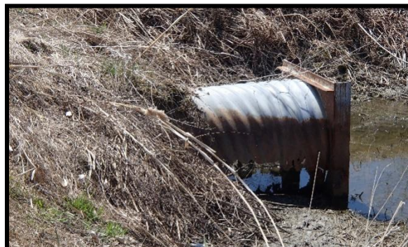
Ponceaux des segments 6 et 7
