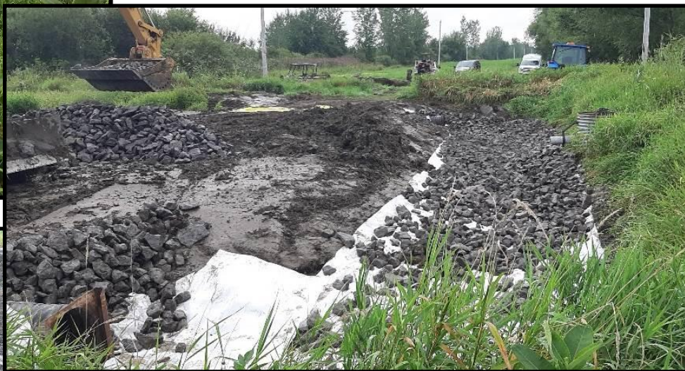
Fosse de sédimentation à la sortie de la station de pompage
