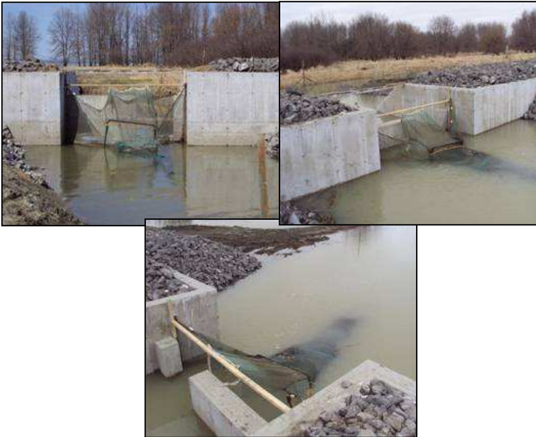
Figure 5. Montage du filet-trappe utilisé lors du suivi de la montaison à la structure de contrôle du segment 8 du 29 mars au 14 avril 2010.
