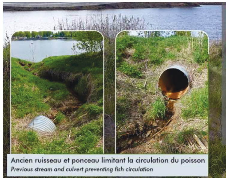
Aménagements réalisés en juillet 2014 et ponceau enfoncé dans le substrat naturel Design completed in July 2014 and culvert dug into natural substrate
