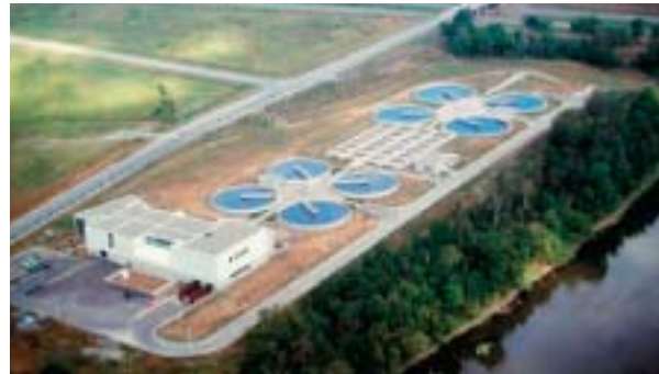
Usine de traitement des eaux usées - L'usine de traitement des eaux usées municipales de Saint-Hyacinthe retourne, une fois traitées, les eaux usées dans la rivière Yamaska, contribuant ainsi à réduire la charge polluante.
