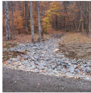
Enrochement - Source : Morin Heights
