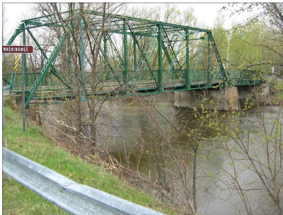
Station d'échantillonnage de la rivière Maskinongé au pont du rang Rivière Sud-Ouest (Photo : Yves Laporte, 2006)
